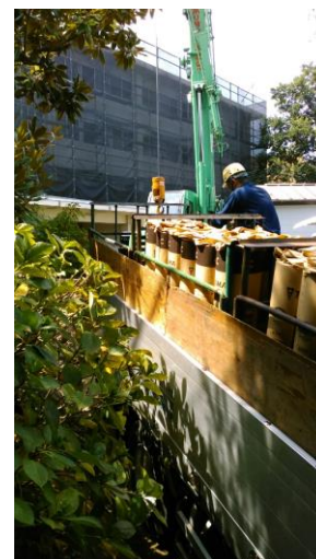
正面入り口より資材を運ぶ作業員 (8月18日撮影)
